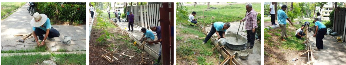
๔.๑๐ ติดตั้งโคมไฟส่องสว่างรั้วหอพักหญิง เพื่อเพิ่มแสงสว่างในเวลากลางคืน
