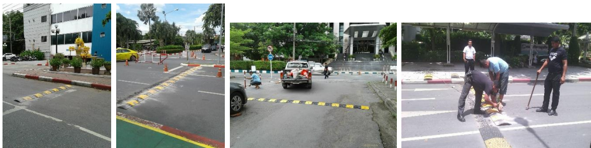
6.14 ดำเนินการซ่อมแซมแผงจราจร
