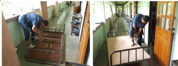
๔.๗ เปลี่ยนหลอดไฟฟ้าส่องสว่างป้ายหอพักนิสิตหญิง
