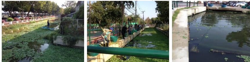
บริเวณคูคลองแนวถนนวิภาวดี
