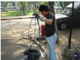
ติดตั้งระบบ ไฟฟ้า
