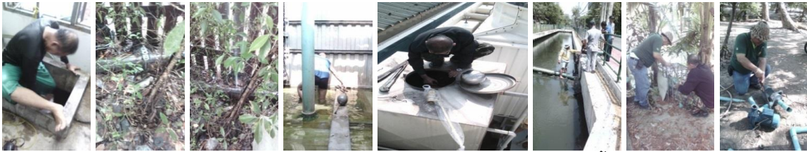
งานอาคารและสถานที่ พัฒนาระบบไฟฟ้าและอุปกรณ์ไฟฟ้า ระบบเครื่องปรับอากาศและเครื่องทำน้ำเย็น ระบบประปาและเปลี่ยนสุขภัณฑ์ห้องสุขา อุปกรณ์โสตทัศนูปกรณ์ และปรับปรุงสภาพแวดล้อมอาคารเรียนส่วนกลาง
