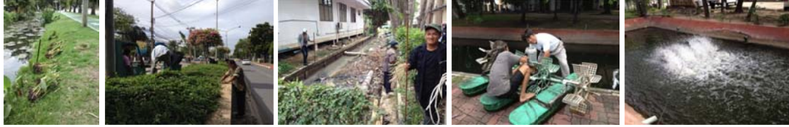
งานซ่อมบำรุงปรับปรุงซ่อมแซมระบบไฟแสงสว่าง ระบบสาธารณูปโภค อาคารเรียนส่วนกลาง
