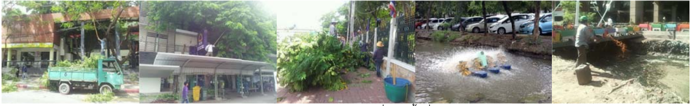
งานซ่อมบำรุง ปรับปรุง/ซ่อมแซมพัฒนาระบบสาธารณูปโภคอาคารสถานที่ และพื้นที่ส่วนกลางมหาวิทยาลัยเกษตรศาสตร์
