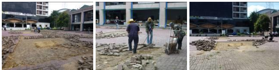
รื้อตัวหนอนซ่อมแซมลานกิจกรรมหน้าอาคารเทพศาสตร์สถิตย์ ที่มา: งานสวนและรักษาความสะอาด (๑๙ ส.ค. ๕๖)
