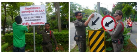
ติดตั้งป้ายเครื่องหมายจราจร เพื่อเพิ่มมาตรการดูแลด้านการจราจร
