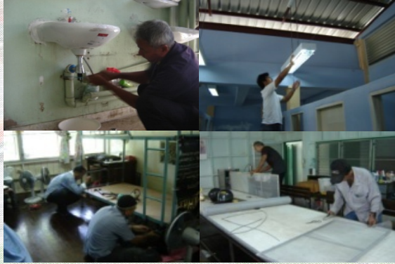
งานอาคารกิจการนิสิตทำการซ่อมแซมสิ่งอำนวยความสะดวกของหอพักนิสิตให้อยู่ในสภาพใช้การได้ตามปกติ ระหว่างวันที่ 7 - 13 กรกฎาคม 2553
