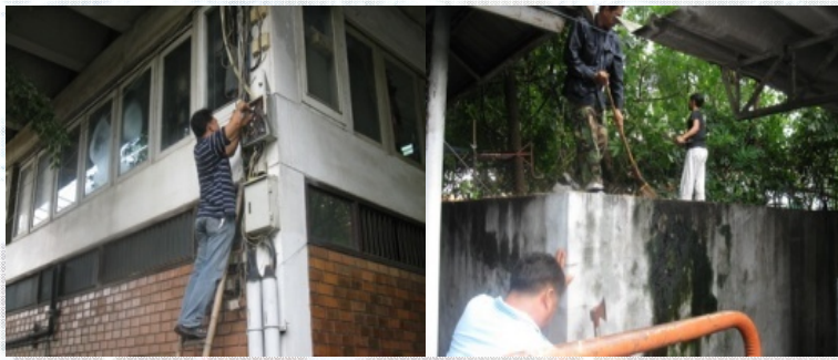
งานซ่อมบำรุงตรวจสอบและเช็คระบบโทรศัพท์ตรวจสอบระบบน้ำประปาให้สามารถใช้งานได้ปกติ 30 กรกฎาคม 2553
