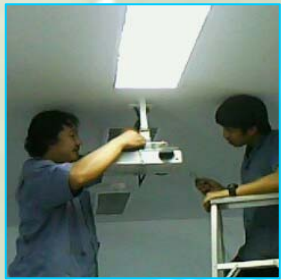
การติดตั้งโซลิตครื่อง LCD เพื่อป้องกันการสูญหาย อาคารศูนย์เรียนรวม 4
