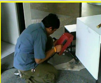
การซ่อมแซมโต๊ะอ่านหนังสือ อาคารศูนย์เรียนรวม 4
