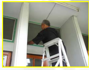
งานซ่อมแซมมุ้งลวดช่องลม ตึกพักชายที่ 5
