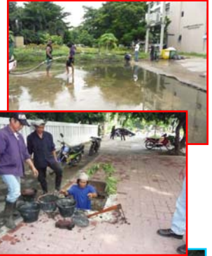
น้ำท่วม เร่ง ขุดลอกท่อระบายน้ำที่จุด ต้นแก้ปัญหาน้ำท่วมขัง แนว ถ.อินทรี ทางเดินเท้า ถ.ชูชาติกำภู และลานจอดรถ ด้านหลังคณะสถาปัตยกรรมศาสตร์ ระหว่างวันที่ 1 -17 กันยายน 2552
