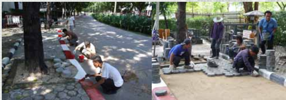
ปรับปรุงพื้นที่ วางท่อระบายน้ำ ทำทางเดินเท้าใหม่ และทาสีเครื่องหมายจราจร หลัง ร.ร.สาธิต มก.
