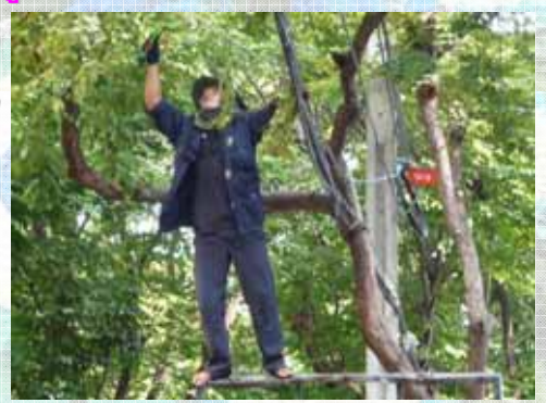
ตัดแต่งกิ่งไม้ ป้องกันเกี่ยวสายไฟ
